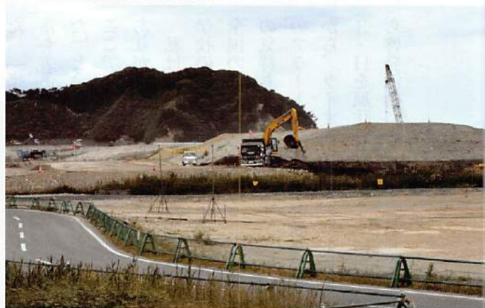
津波により壊滅的な被害を受けた薄磯海岸(上)では現在、大規模なかさ上げ工事が進んでいる(下)
